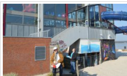
Gert Mißfeldt (links) und Michael Meggle schlagen ein Therapie- und Wärmebecken auf dem Dach des rot verklinkerten Blockheizkraftwerks an der Meerwasserschwimmhalle in Laboe vor. ©
